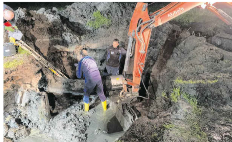
Die Gussleitung aus den 1970er-Jahren wird im Scheinwerferlicht repariert.
