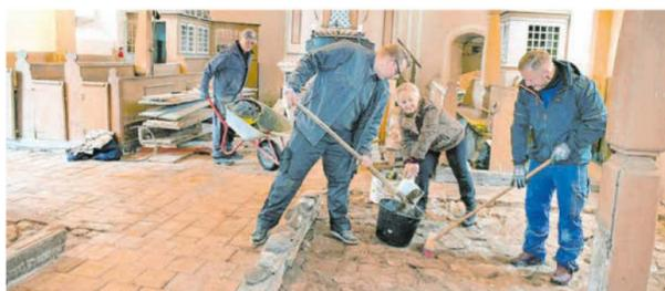
Unter dem alten Fußboden war eine Isolierschicht aus Sand, Sägespänen und Spreu eingebaut.
