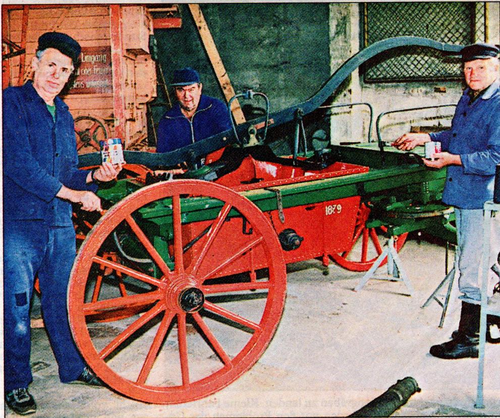
Der ganze Stolz der Gordener ist die Zwei-Kolben-Handdruckspritze aus dem Jahre 1879.
