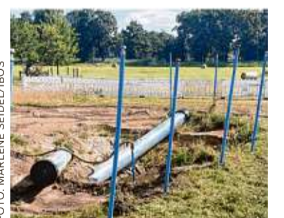
Im August liegt die neue Trinkwasserhauptleitung vom Wasserwerk Oschätzchen in Haida. Foto: MARLENE SEIDEL/IBOS
